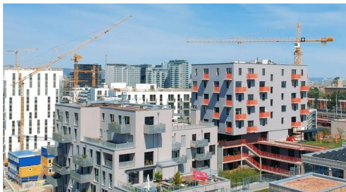
Figure D3: Sonnwendviertel Housing Source: IBA Vienna
